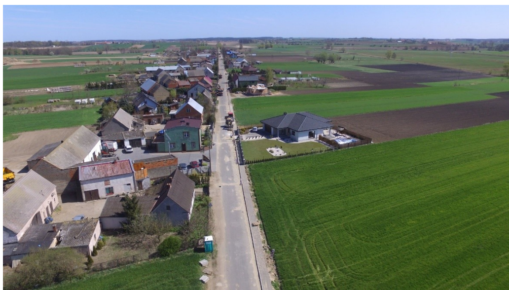
Fot. Przebudowa drogi w miejscowości Kąty (Maciejewo)
