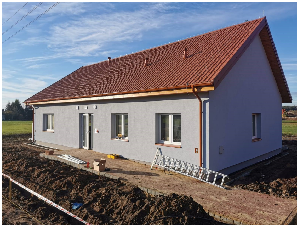
Fot. Gminny Żłobek w Kąkolewie w końcowej fazie budowy.
