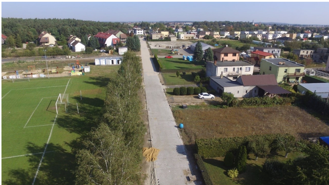
Fot. Przebudowa ul. Sosnowej w Kąkolewie
