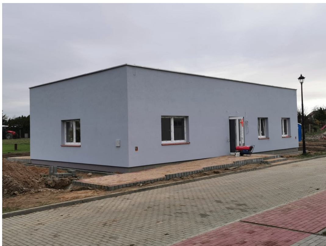
Fot. Gminny Żłobek w Osiecznej w końcowej fazie budowy.
