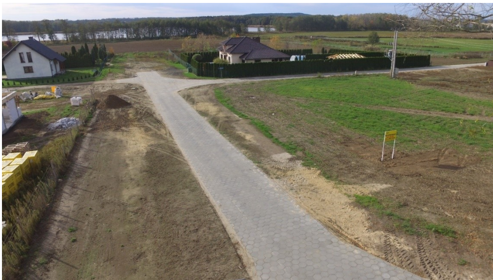
Przebudowana droga gminna w Świerczynie
