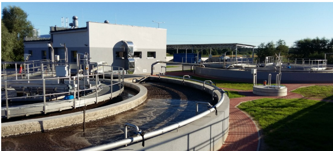
Oczyszczalnia ścieków w Osiecznej
