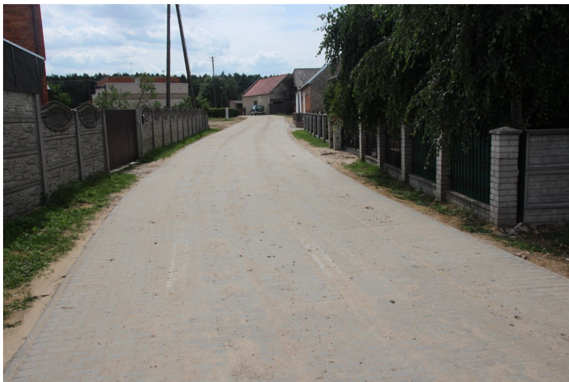
Przebudowana droga gminna w Grodzisku
