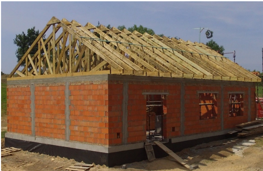
Świetlica wiejska w Jeziorkach podczas budowy
