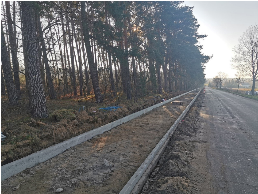
Budowa ścieżki rowerowej w rejonie Grodziska
