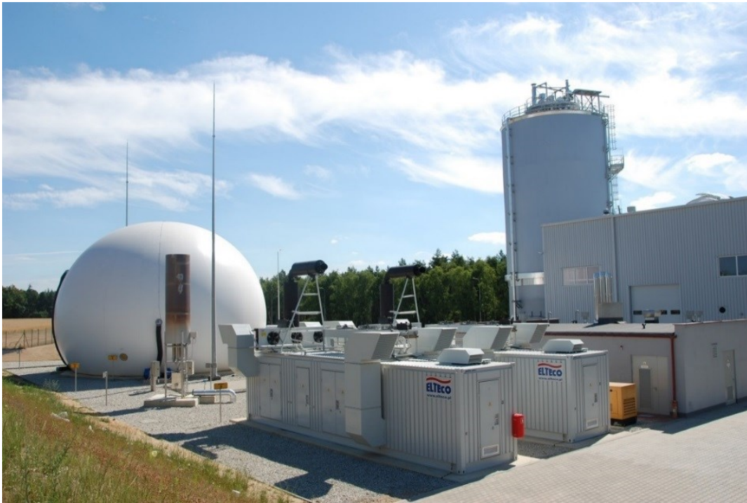
Zakład zagospodarowania odpadów w Trzebani
