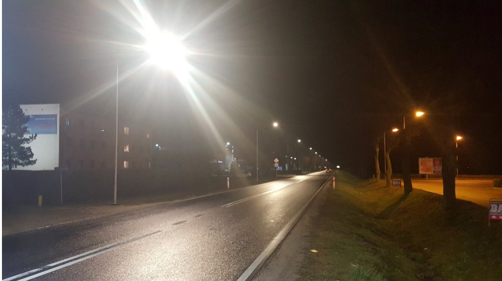
Oświetlenie uliczne w Kąkolewie
