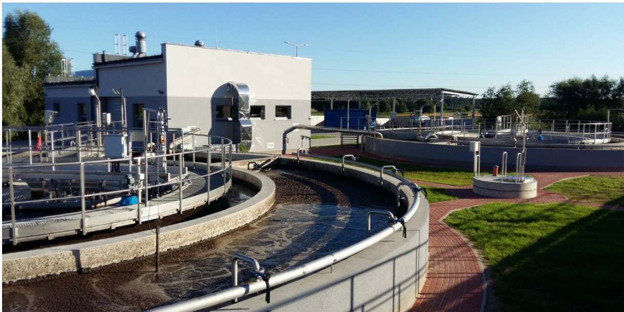
Oczyszczalnia ścieków w Osiecznej
