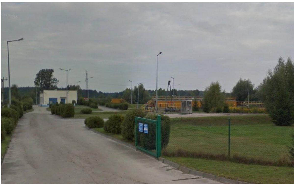
Rys. 6 . Komunalna oczyszczalnia ścieków w Osiecznej
