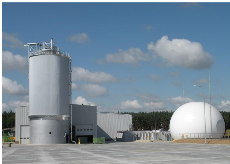
Rys. 8. Zakład Zagospodarowania Odpadów w Trzebani - komora fermentacyjna
