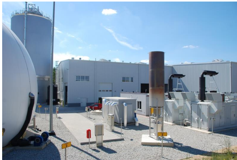
Rys. 9. Zakład Zagospodarowania Odpadów w Trzebani- hala technologiczna
