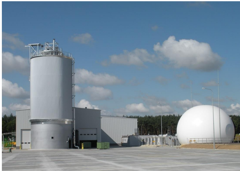
Rys. 8. Zakład Zagospodarowania Odpadów w Trzebani - komora fermentacyjna
