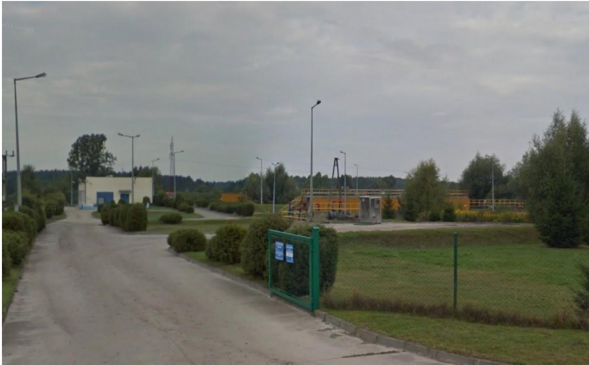
Rys. 6 . Komunalna oczyszczalnia ścieków w Osiecznej
