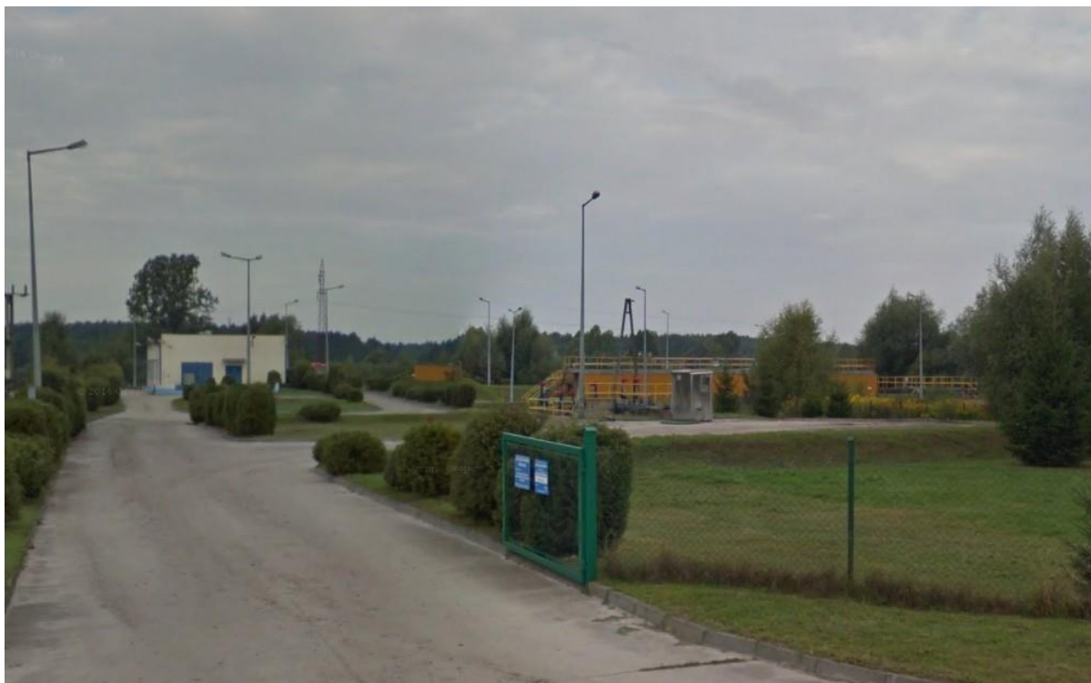
Rys. 6 . Komunalna oczyszczalnia ścieków w Osiecznej
