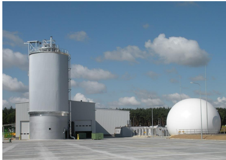
Rys. 8. Zakład Zagospodarowania Odpadów w Trzebani - komora fermentacyjna
